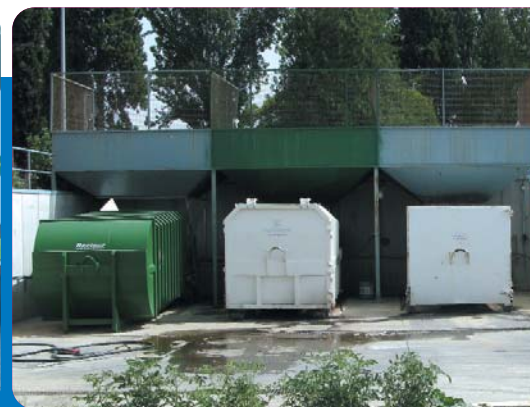
Compactadores en el punto limpio
